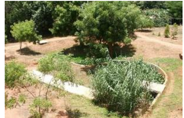
Traitement biologique des eaux
