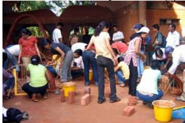
Construction d'arcs, de voûtes et de dômes
