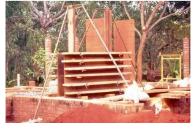
Coffrage pour le pisé
