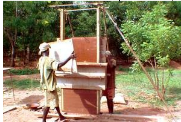
E Mur en pisé stabilisé
