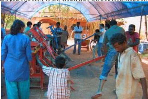
Production de blocs
