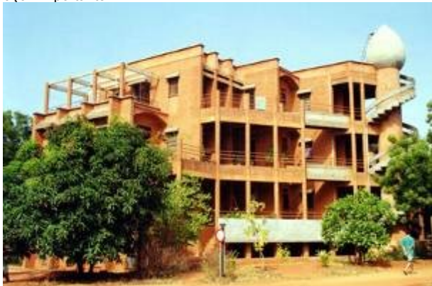
Bâtiment en terre stabilisée sur 4 étages
