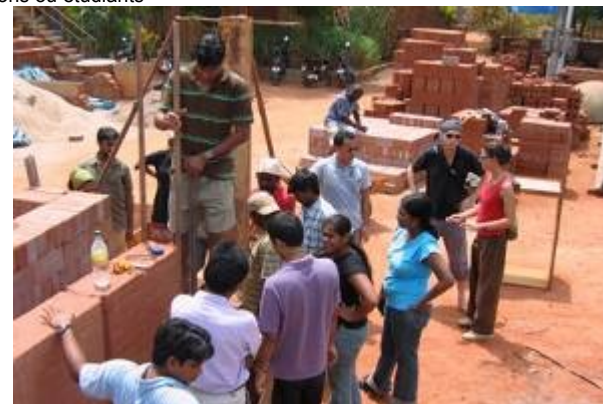
Mur en pisé stabilisé
