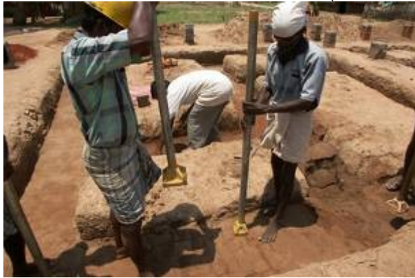
Fondations en pisé stabilisé
