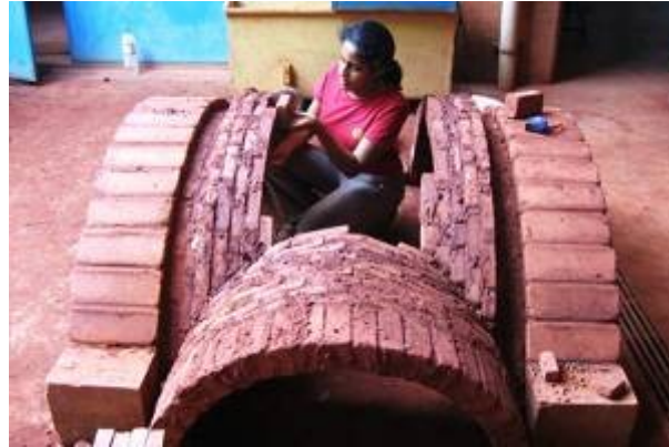
Construction de voûtes
