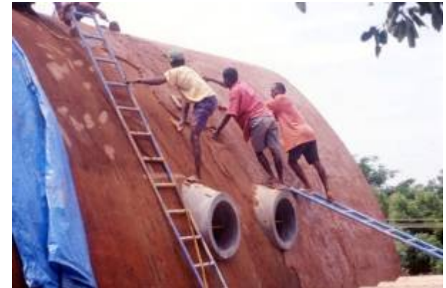
Etanchéité à base de terre stabilisée
