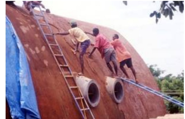
Etanchéité à base de terre stabilisée
