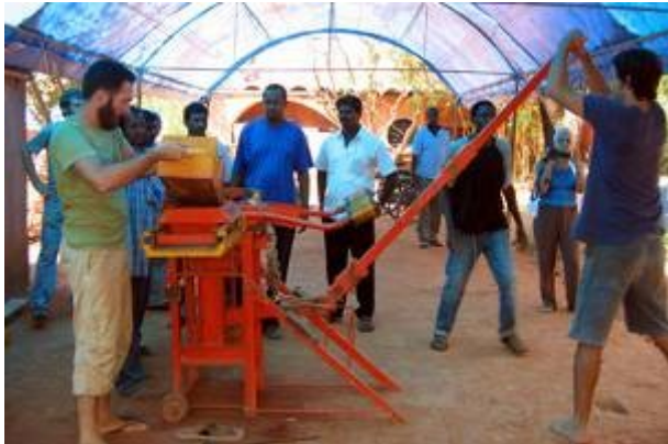
Production de blocs
