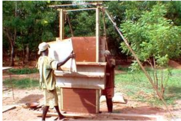
E Mur en pisé stabilisé
