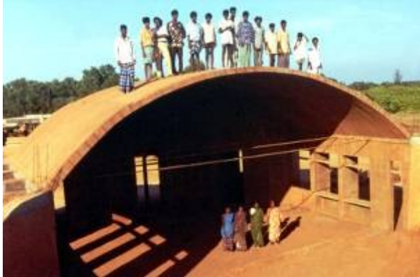
Voûte surbaissée – 10.35 m span
