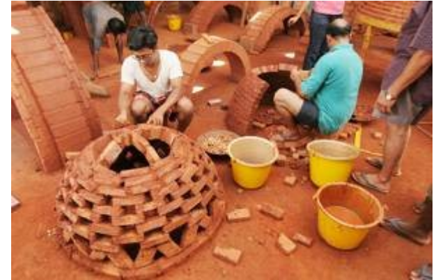
Construction de dômes
