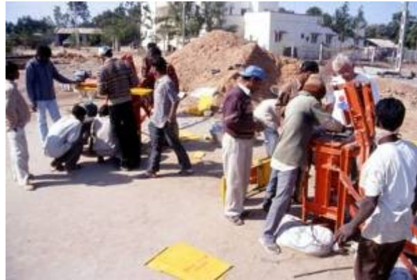
Production de blocs à emboîtement creux
