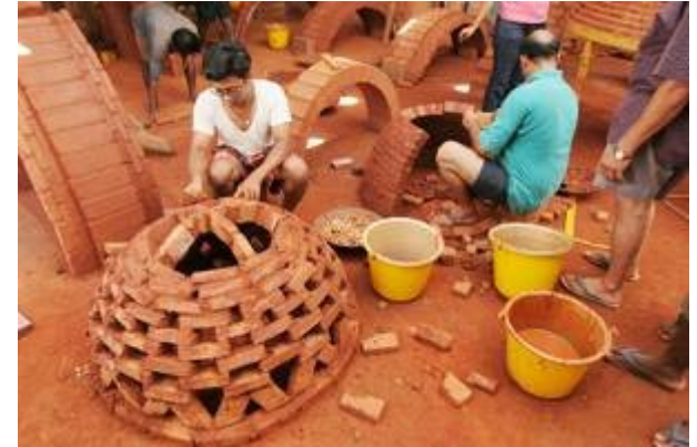
Construction de dômes
