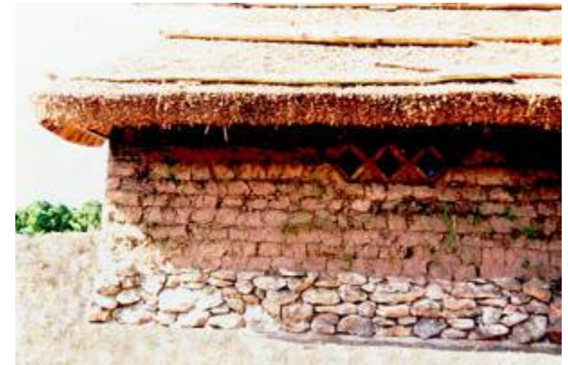
Uruguay, Montevideo – Sod wall (Photo H. Guillaud)
