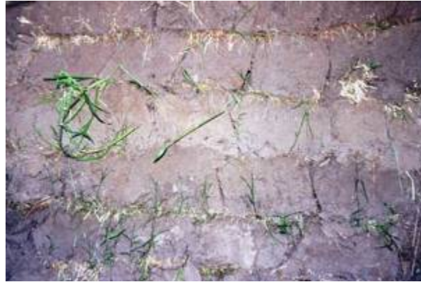
Uruguay, Montevideo – Sod wall (Photo H. Guillaud)
