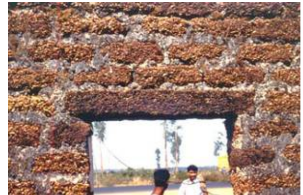
Inde, Orissa, près de Bhubaneshwar – Linteau de 75 cm de portée
