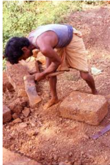
Inde, Orissa, Narangarh – Taille d'un bloc de petroplinthite
