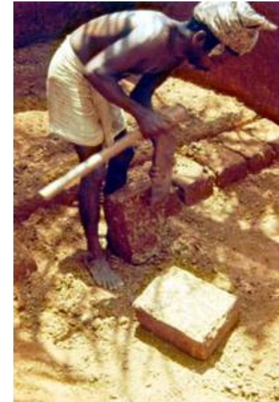
Inde, Kerala, près de Soranad – Taille d'un bloc de plinthe
