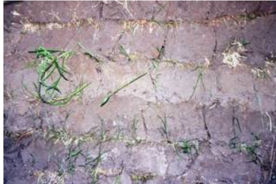
Uruguay, Montevideo – Sod wall (Photo H. Guillaud)
