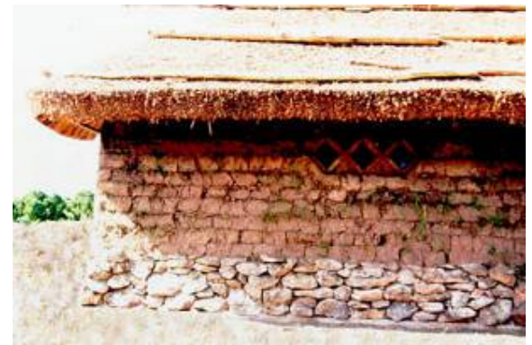
Uruguay, Montevideo – Sod wall (Photo H. Guillaud)
